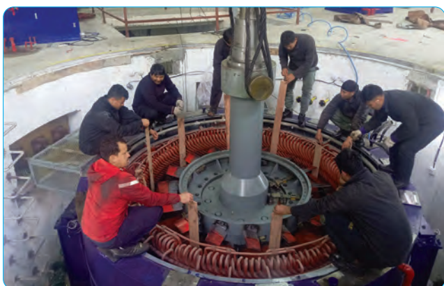
मेसिन युनिट नं. १ को Overhauling
