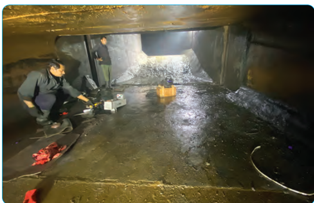
Draft Tube को स्टिल लाइनिङ मर्मत
