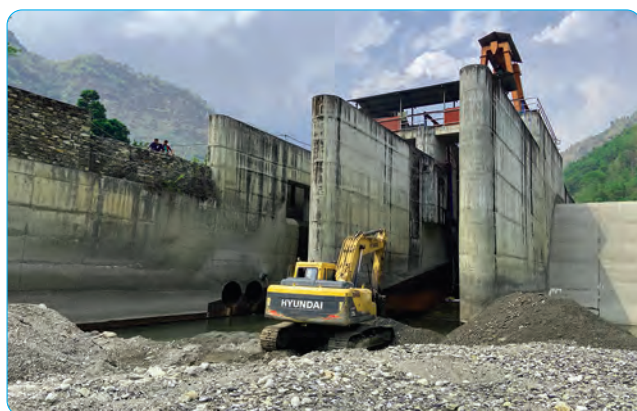
Undersluice Stilling Basin मर्मत सम्भार
