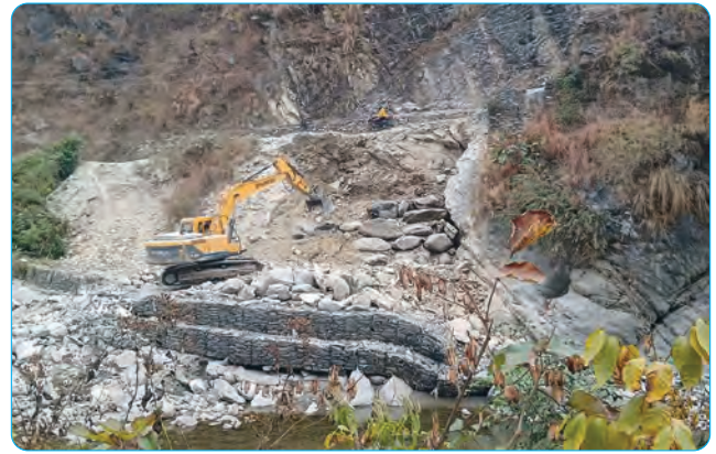
नदि कटान सुरक्षण संरचना निर्माण
