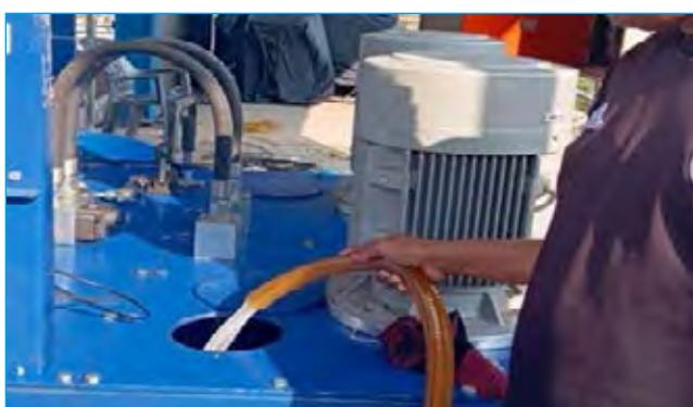
रेडियल गेटको hydraulic power pack मा तेल परिवर्तन
