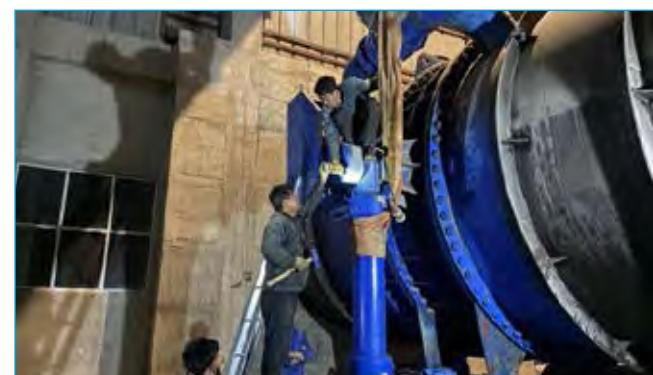
PPV को हाईड्रोलिक O-Ring पाइपको मर्त
