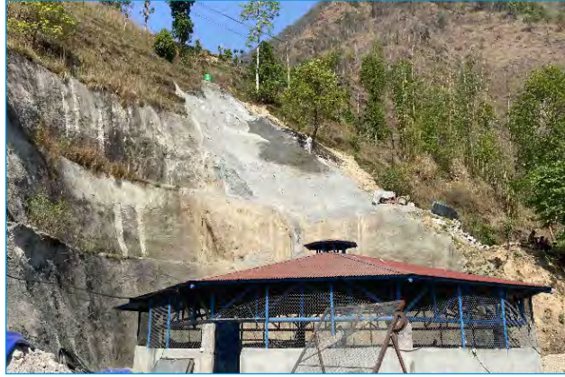
सर्ज साफ्टको माथिल्लो भागमा पहिरो गएको स्थानमा Slope Stabilization
