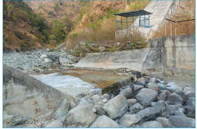
पोकु खोल्सी क्रसिङ्ग Anchor Block को मर्मत
